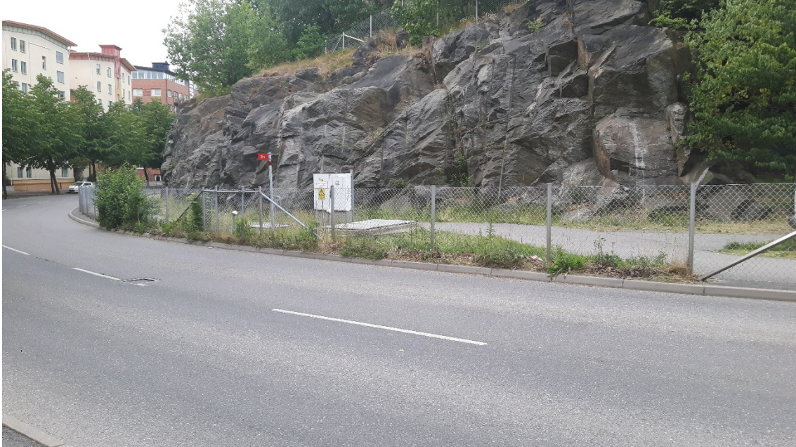
Figur 1. Befintlig spillvattenpumpstation vid Östra Eriksbergsgatan
